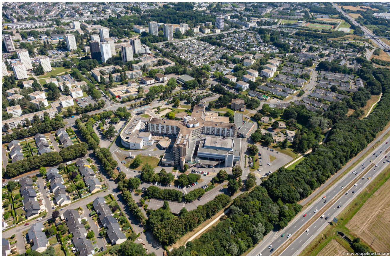
VUE AÉRIENNE SUR L'HÔPITAL SUD FR-RENNES-PS-AP02 © Sabine De Villeroy Juin 2018
