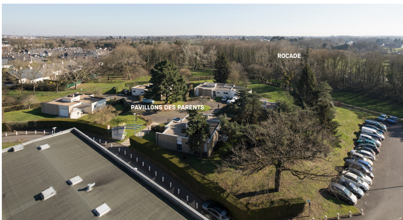
VUE SUR LA MAISON DES PARENTS ET LE RIDEAU VÉGÉTAL DE LA ROCADE FR-RENNES-PS-P46 © Anne-Cécile Estève
