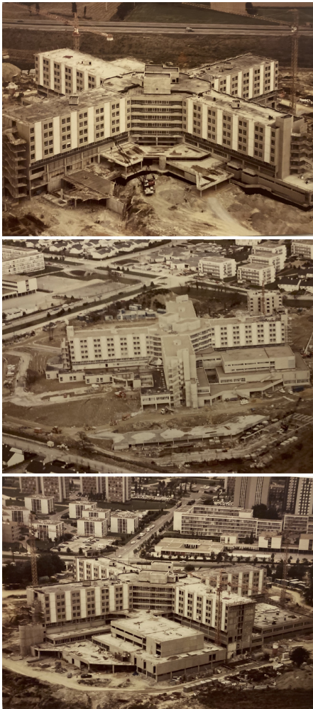
CONSTRUCTION DE L'HÔPITAL - MAI 1978 FR-RENNES-PS-P70
