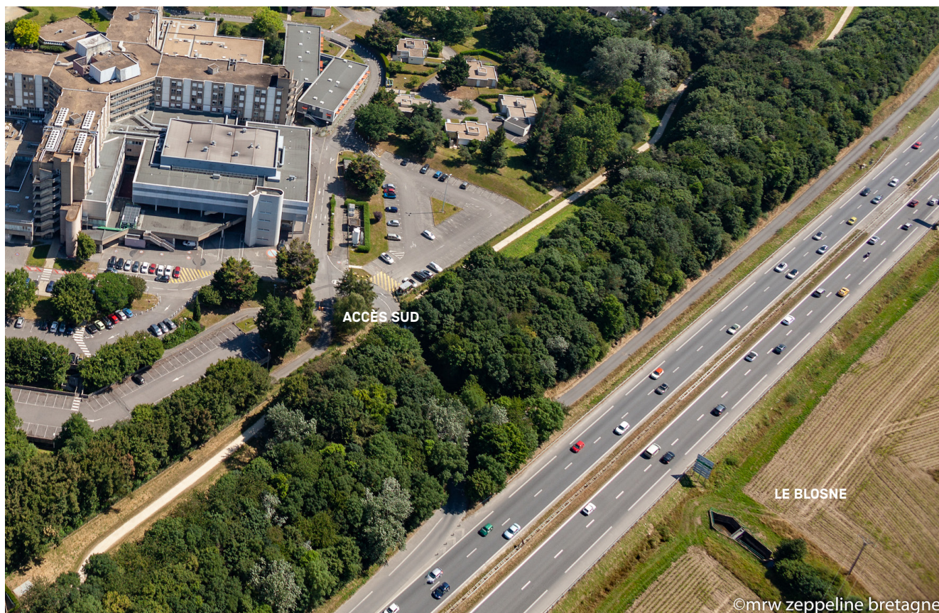
VUE SUR LA ROCADE ET L'ENTRÉE DU DALOT DU BLOSNE FR-RENNES-SS-AP04 © Sabine De Villeroy Juin 2018
