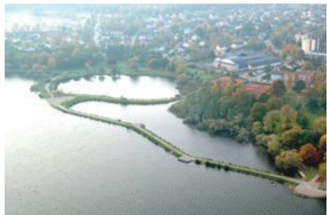
Lagoons for stormwater management in Växjösjön
