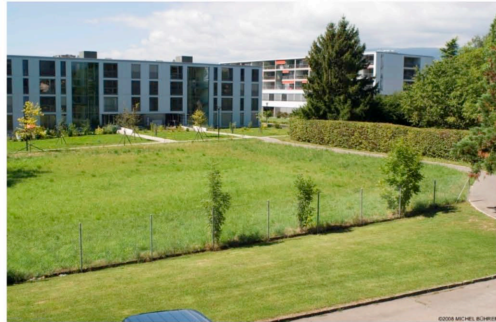
An den Studienperimeter angrenzende Konstruktionen
