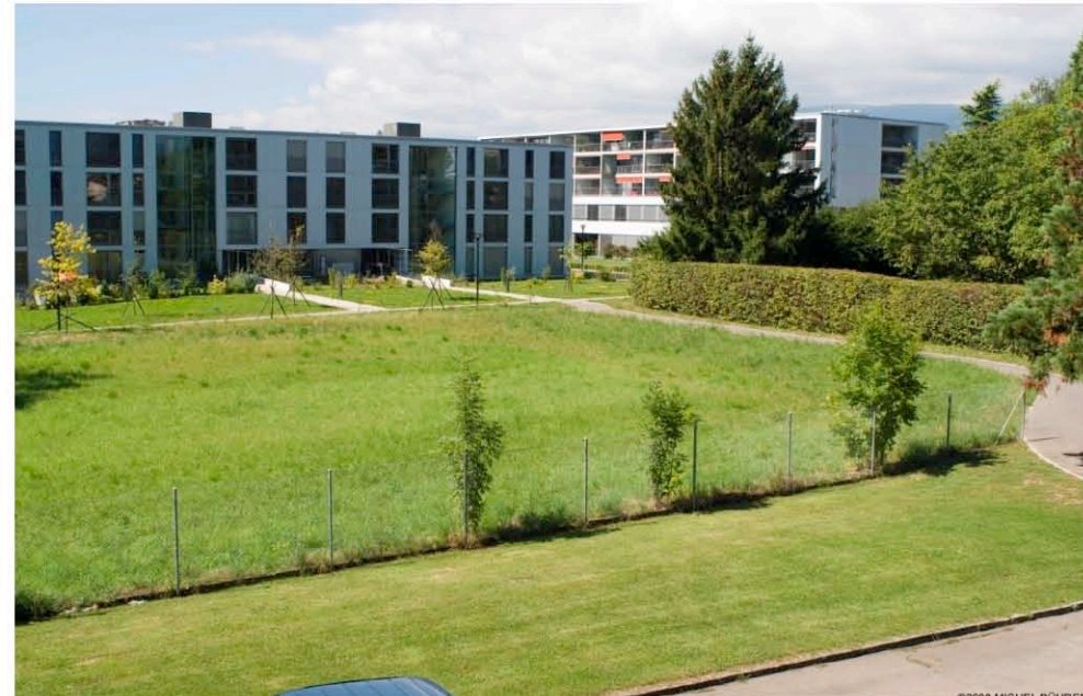
Les constructions jouxtant le site d'étude
