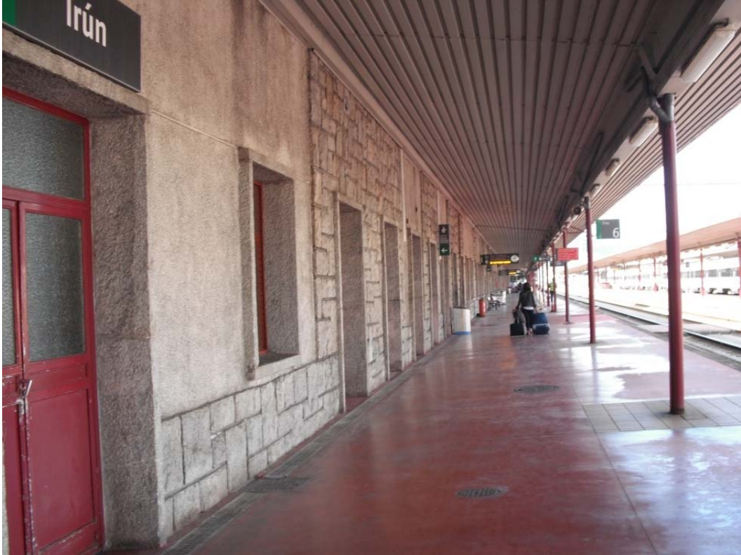
Andenes de la estación
