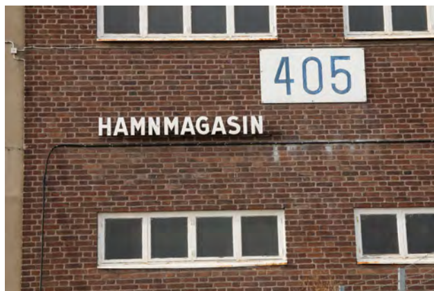
Magasin 405, Helsingborgstegel i fasad
