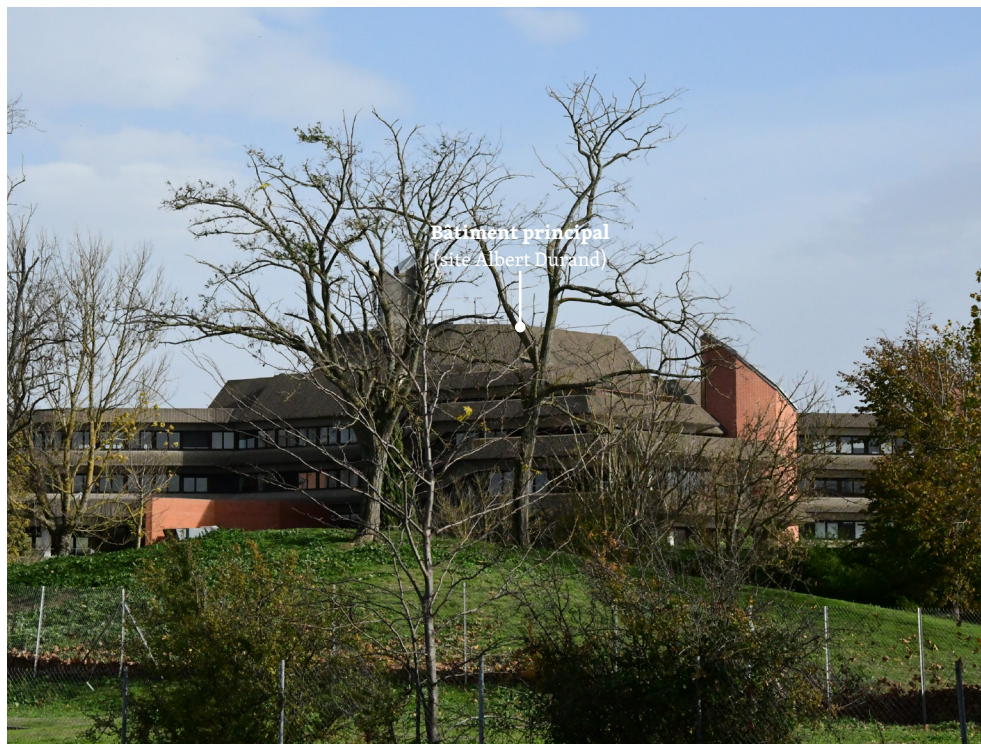
UN SITE ARBORÉ À PROXIMITÉ DE L'AÉROPORT Vue extérieure nord-ouest du bâtiment principal depuis l'avenue de Londres
