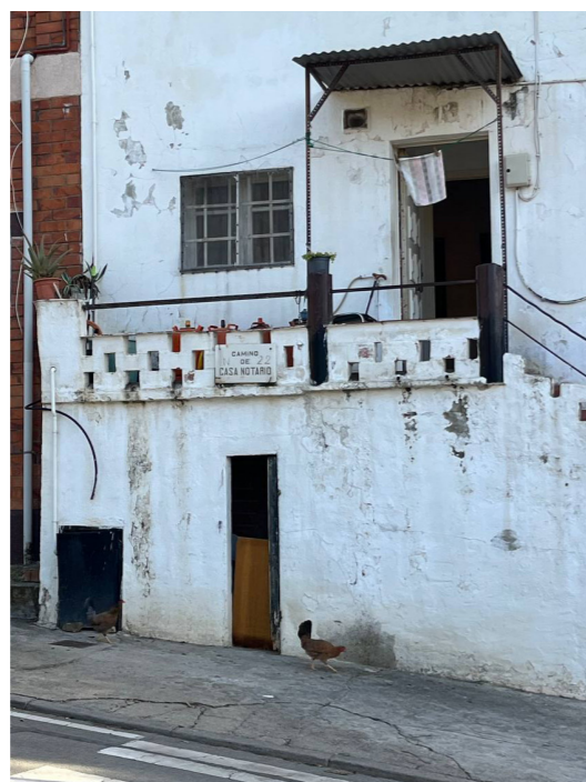
Izquierda: Imágenes a pie de calle del área de proyecto. Fuente: Elaboración propia.
