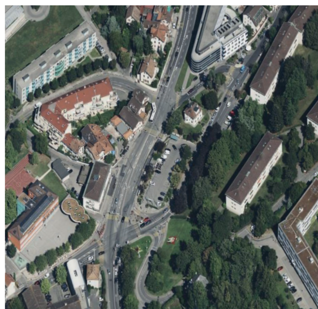
Site No 9. Place de Carantec, Le Grand-Saconnex
