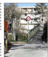
La passerelle située au bout de l'avenue de la Butière, vers les HLM de la cité Caramy, va être déplacée.
