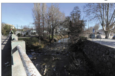
Au niveau de la passerelle Sadi-Carnot, les travaux concernent, outre les berges, le remplacement et l'agrandissement de ce pont. Le city-stade, lui, sera déconstruit. (Photos Gilbert Broussard)
