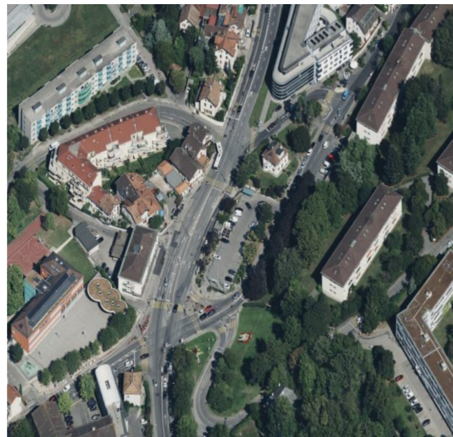
Site No 9. Place de Carantec, Le Grand-Saconnex
