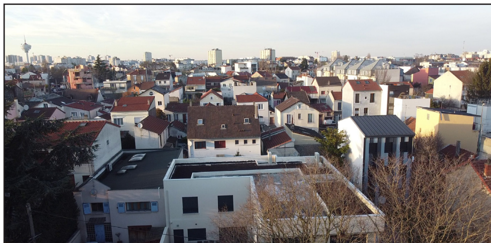
VUE OBLIQUE DU QUARTIER DES ORMES - PRISE DE VUE EN LIMITE SUD DU SECTEUR DE PROJET
