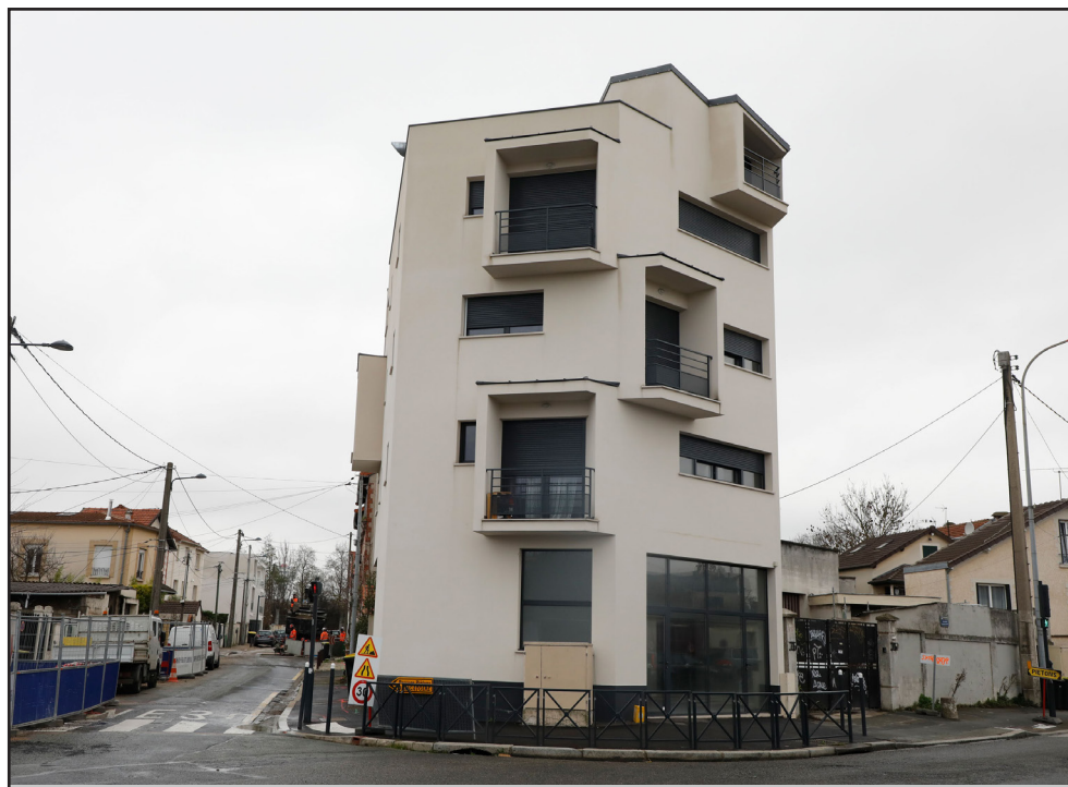
RENOUVELLEMENT URBAIN DU QUARTIER PAVILLONNAIRE (Ville de Romainville)
