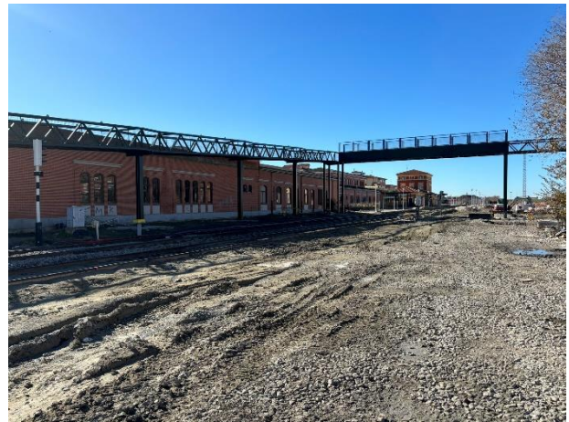
Fotografía 8. Pasarela elevada de nueva construcción
