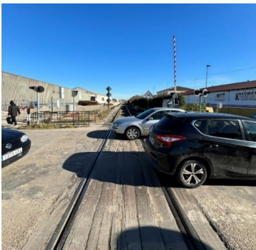
Fotografía 1. Paso a nivel existente
