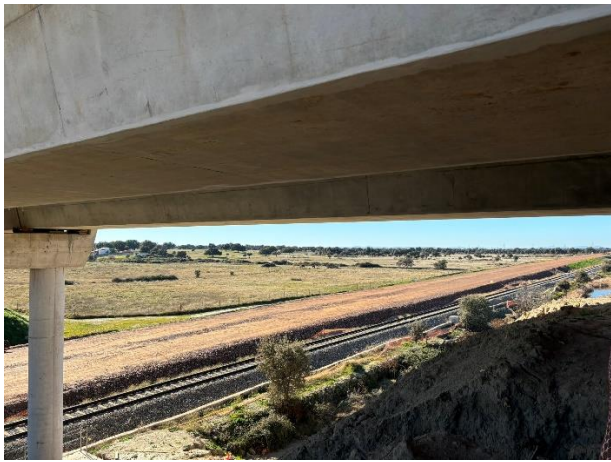
Fotografía 8. Vista de vías debajo de paso elevado
