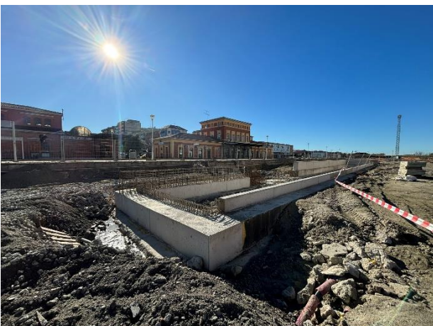
Fotografía 9. Obras de adecuación de pasos
