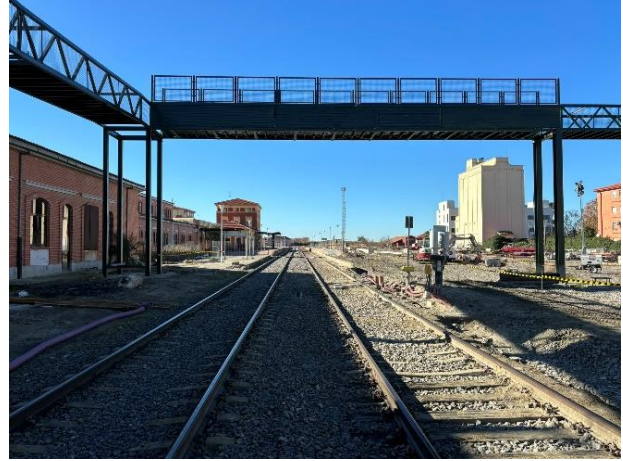
Fotografía 7. Pasarela elevada de nueva construcción
