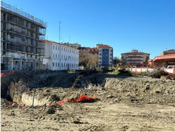
Fotografía 6. Obras de adecuación de pasos
