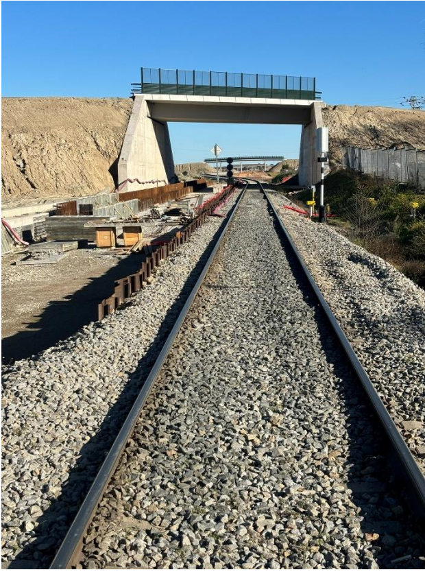
Fotografía 11. Obras en las vías del tren y paso elevado
