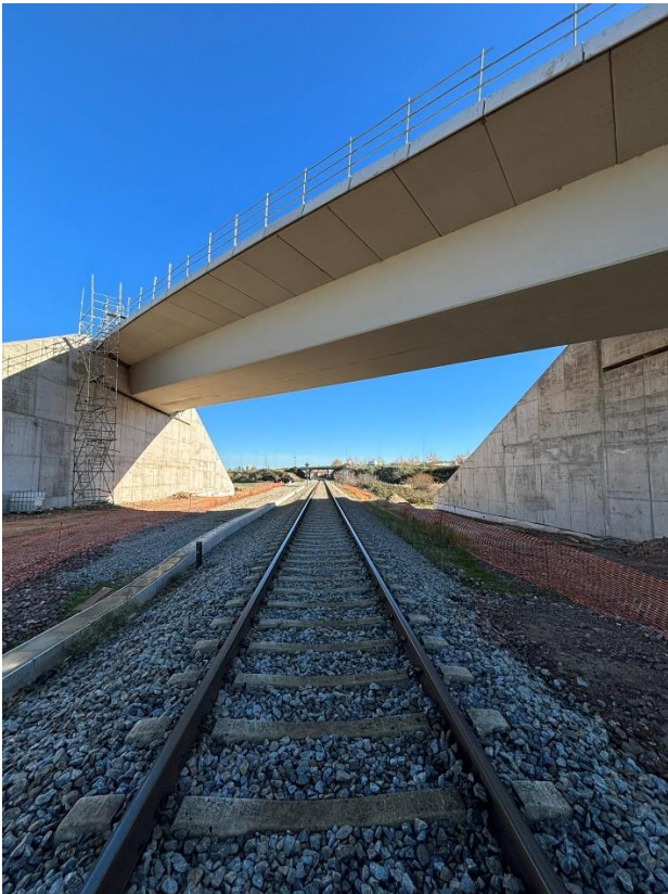
Fotografía 13. Paso elevado sobre la vía del tren
