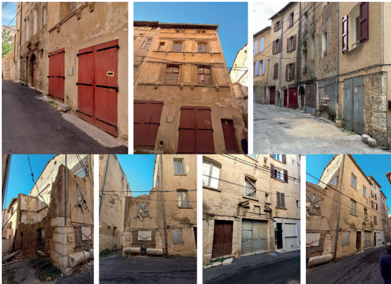
IMMEUBLES DE LA GRAND RUE FR-RIEZ-PS-P1
