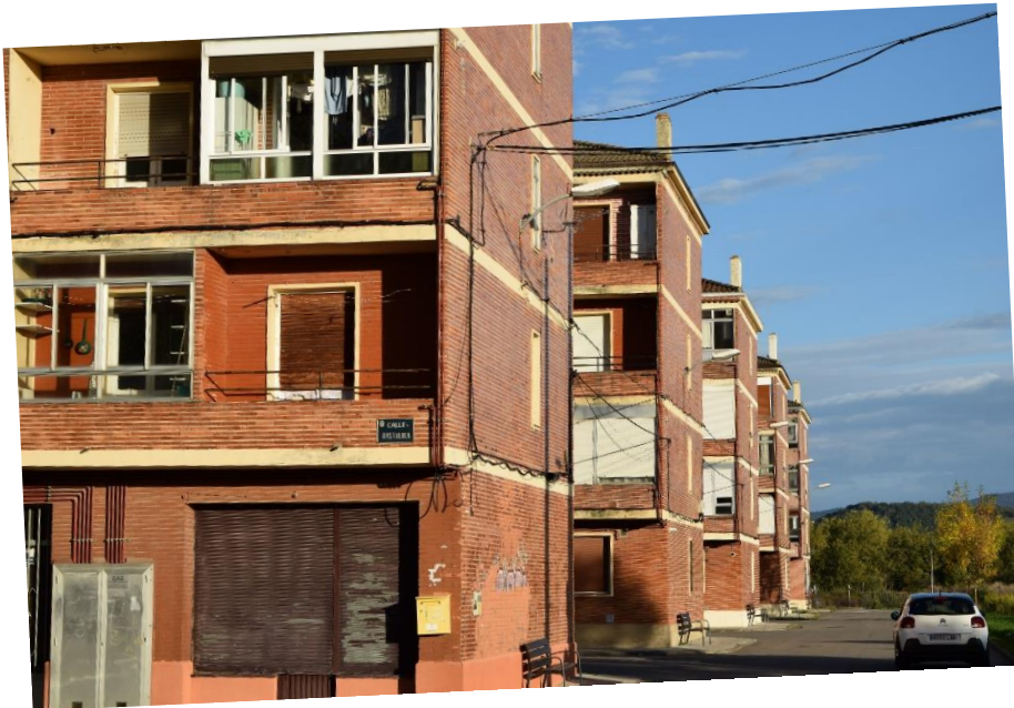
6. Vista a pie de calle desde el oeste 6. Street view from west
