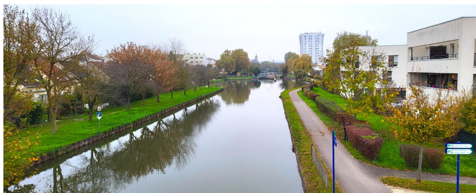
SITE 4 VUE DEPUIS LA PASSERELLE DE LA CALIFORNIE FR-NANCY-PS4-P03
