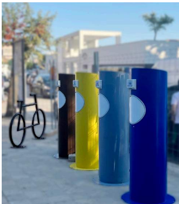
Nuovo sistema di raccolta rifiuti pneumatico - in fase di collaudo
