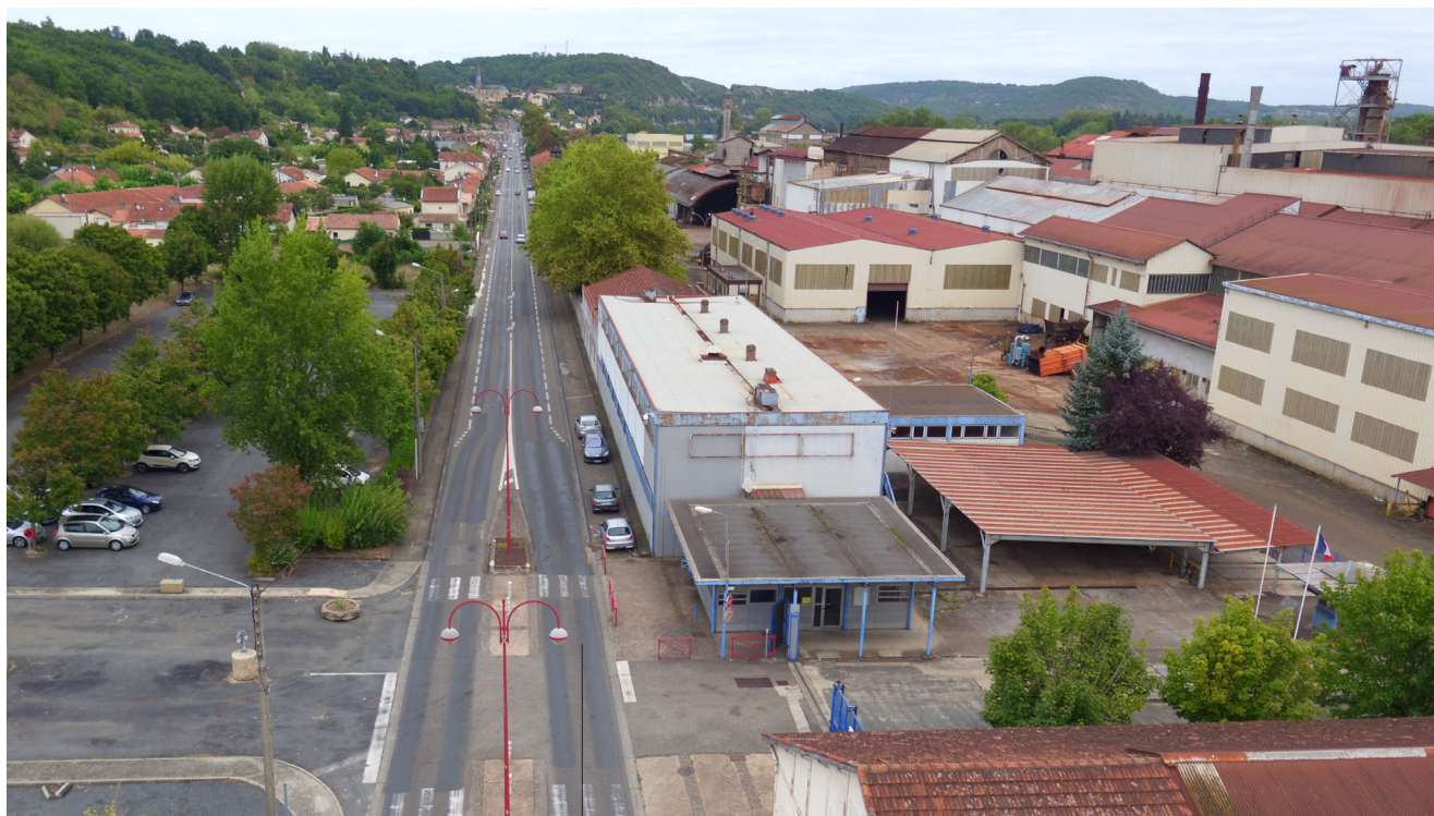
AVENUE DE L'USINE
