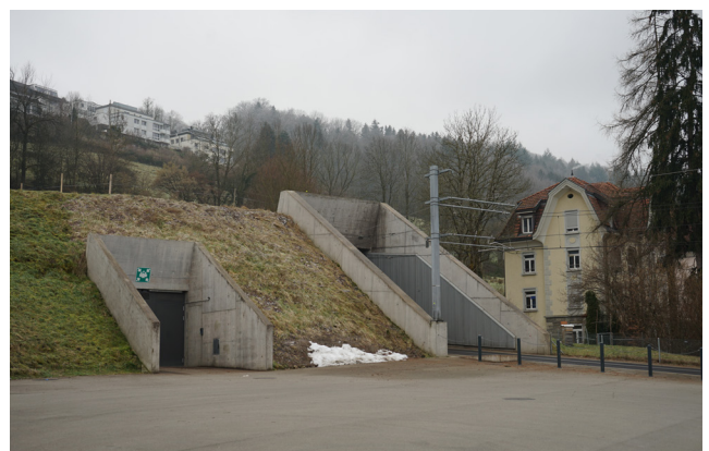
Eingang in den Ruckhaldetunnel tunnel inlet
