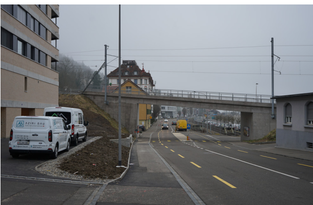
Bahnbrücke an der Oberstrasse railroad bridge at Oberstrasse
