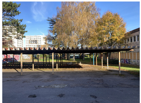
VUE INTÉRIEURE DU SITE DE L'ANCIEN COLLÈGE
