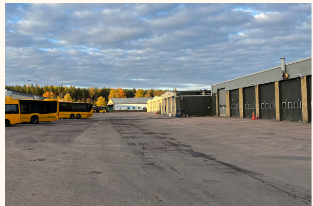
Bus depot (4). Photo: Karlstads kommun.
