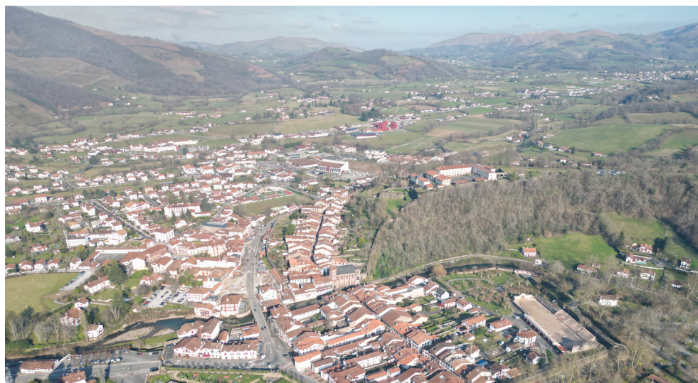
SITE DE PROJET «SAINT-JEAN-PIED-DE-PORT – PONT D'EYHERABERRY»
