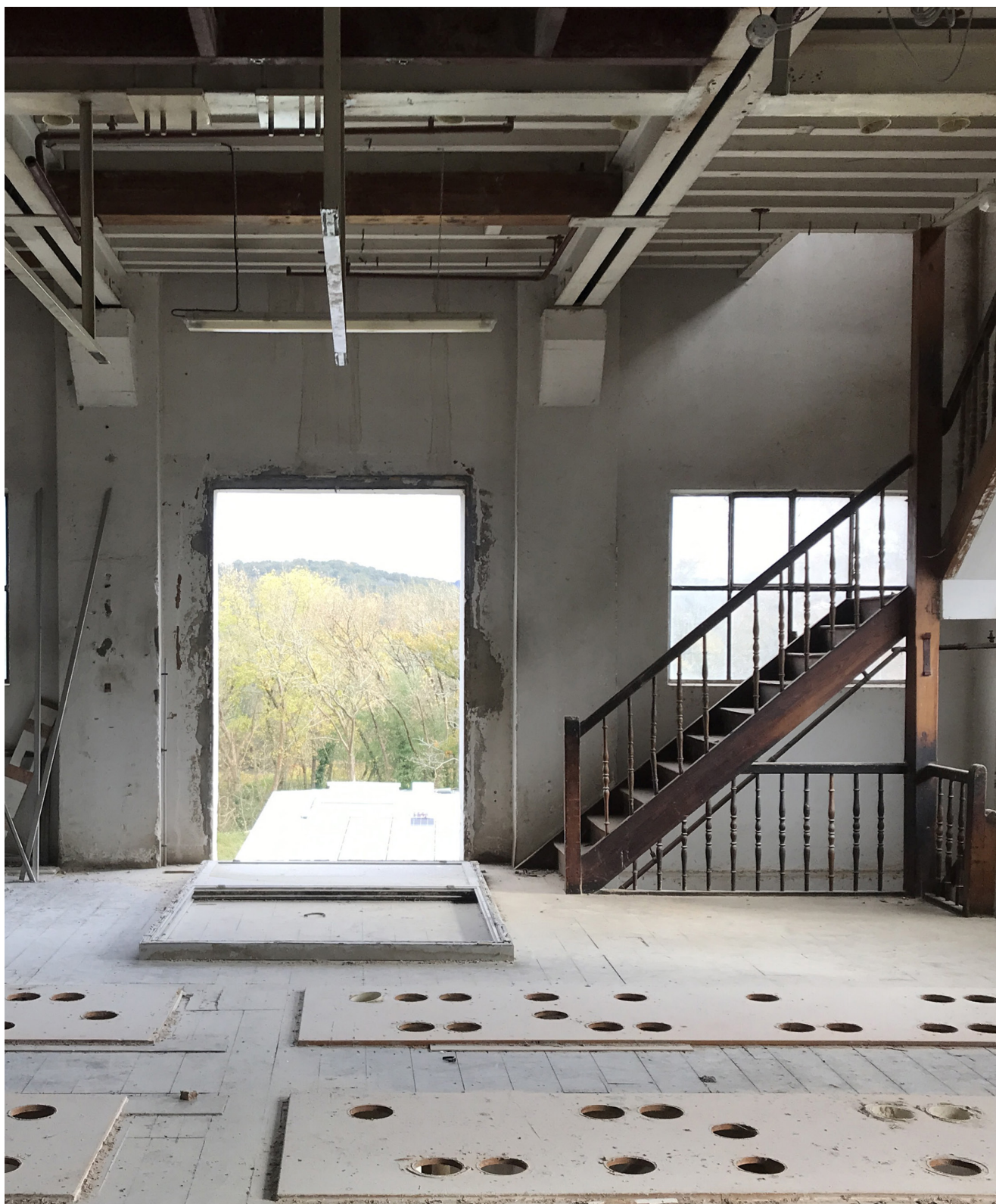
VUE DEPUIS LA MINOTERIE À USTARITZ
